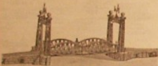
Pont de chemin de fer, construction métallique, deux pontons en fer forgé. Hauteur 2 m. et 2 m 50.
