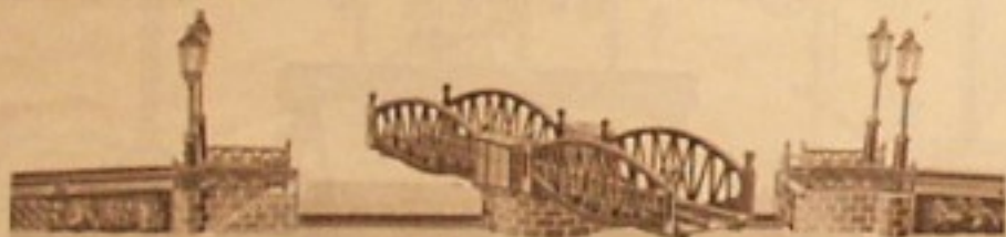
Pont de chemin de fer, construction métallique, deux pontons en fer forgé. Hauteur 2 m. et 2 m 50.
